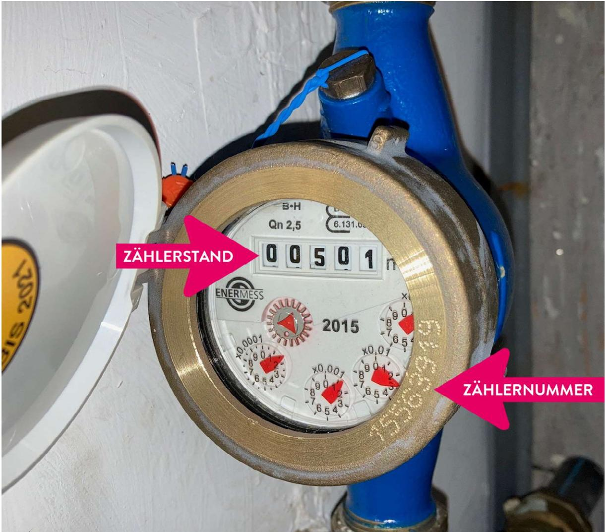
Wasserzähler mit Zählerstand und Zählernummer auf der Einfassung.
